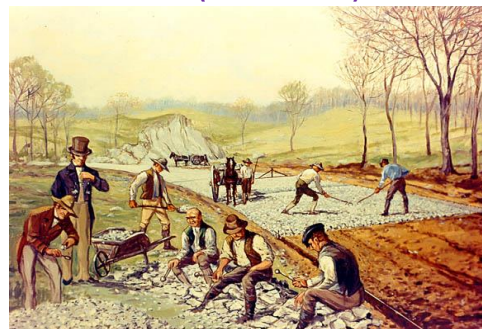
Строительство дороги Мак-Адамом
